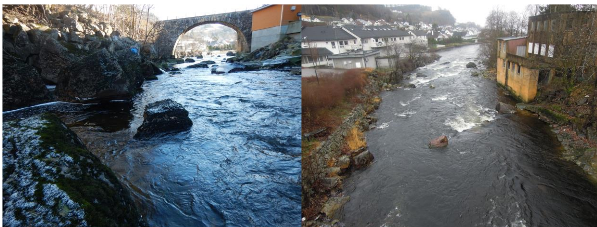
Figur 27. Dagens situasjon over (venstre) og nedenfor steinhvelvbru. Det er en del blokker og stein i løpet.
