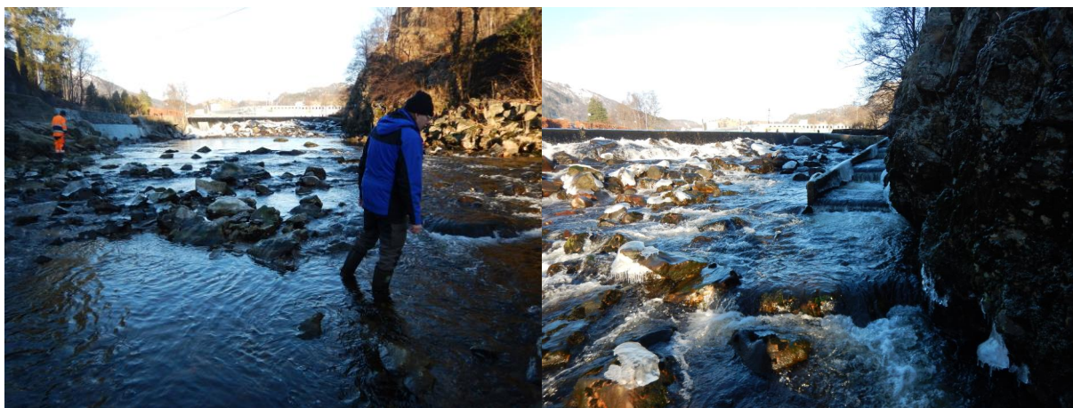
Figur 26. Dagens situasjon i forhold til stein og blokk i løpet under terskel og ved fisketrapp.
