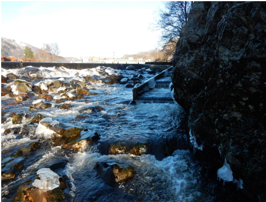
Figur 23. Fisketrapp ved terskel for Fossekallen kraftverk.
